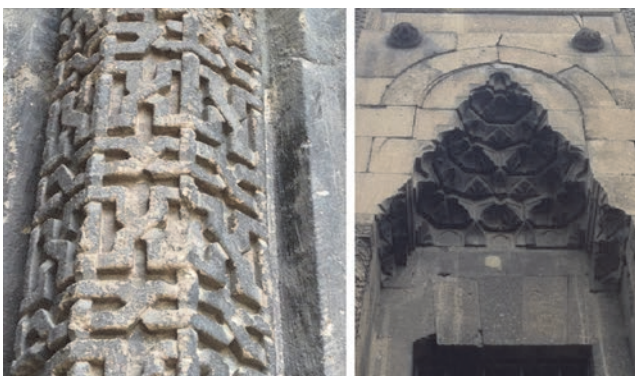
Slika 3. Dekorativni konstrukcijski elementi
